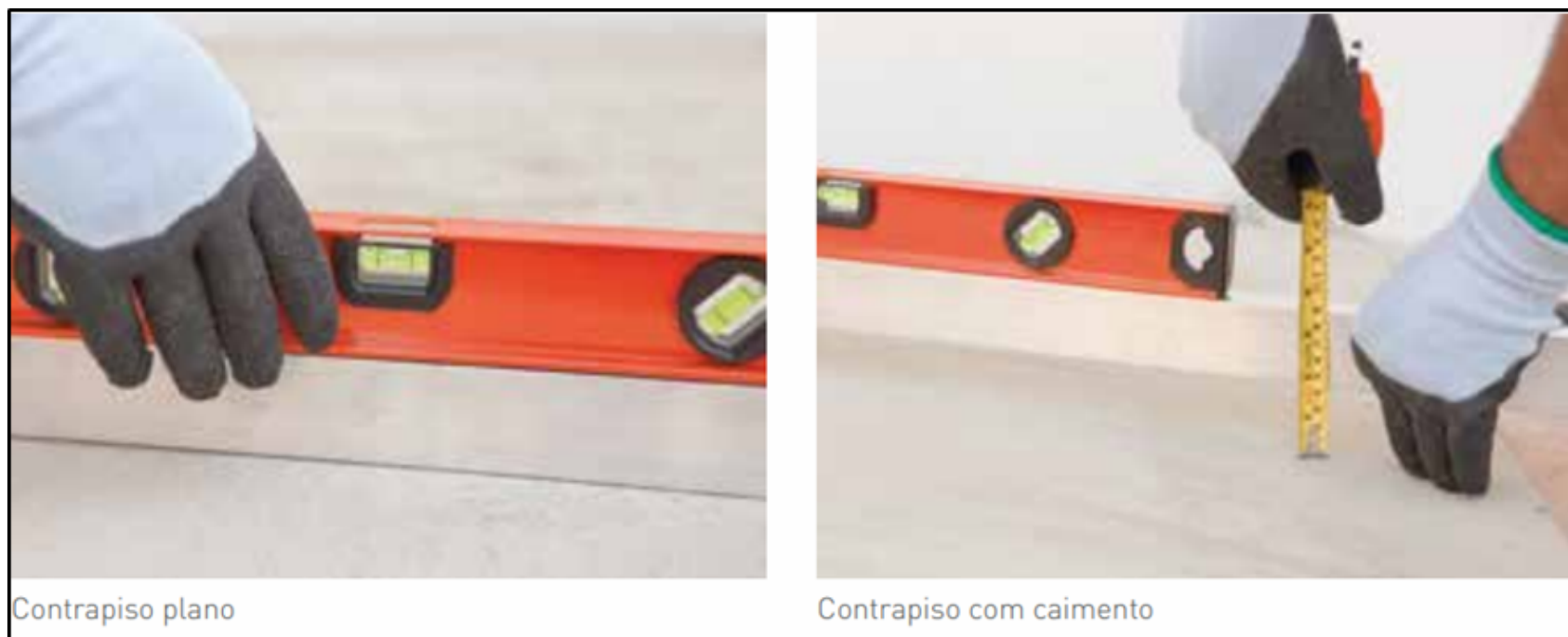
Figura 2 – Verificação do caimento do contrapiso
